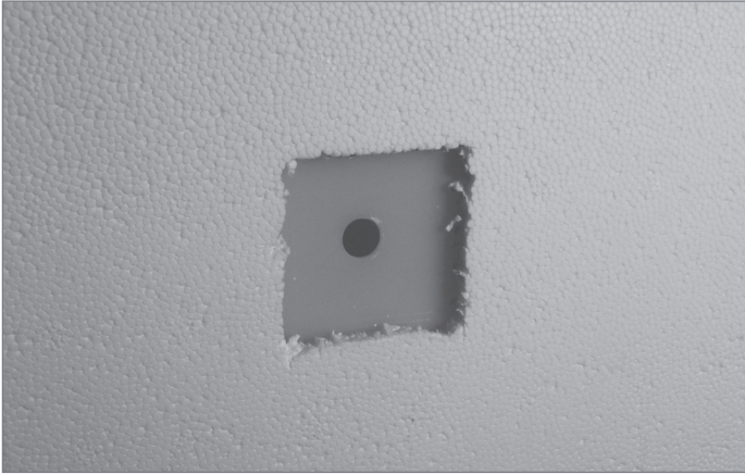
1. Beschädigte Stelle freilegen
