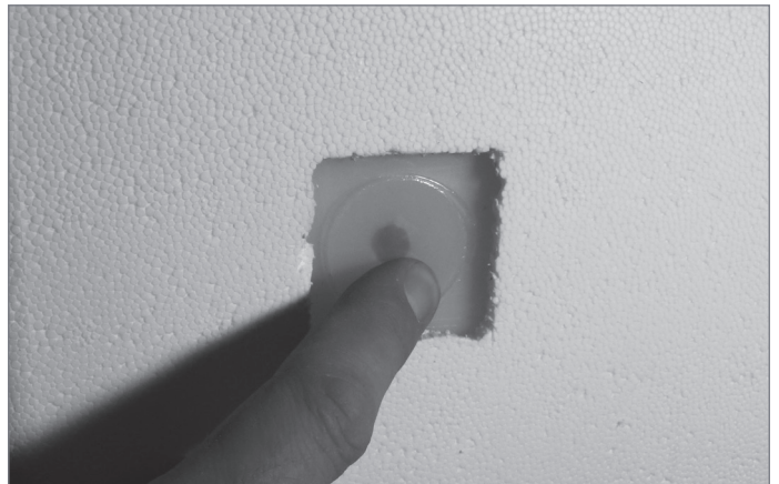
6. Applicare il dischetto immediatamente sul foro, esercitando una breve pressione
